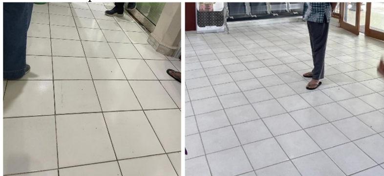
Gambar 4 Kondisi lantai eksisting
