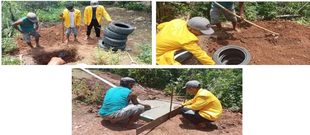
Gambar 4. Tahap pembuatan jamban 3
