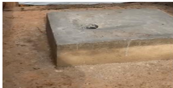
Gambar 5. Tahap pembuatan jamban 4
