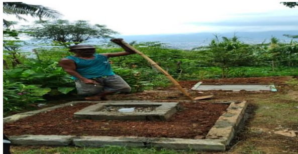
Gambar 2. Tahap pembuatan jamban 1
