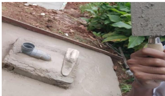
Gambar 3. Tahap pembuatan jamban 2
