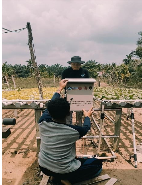
Gambar 11 Pemasangan panel kontrol
