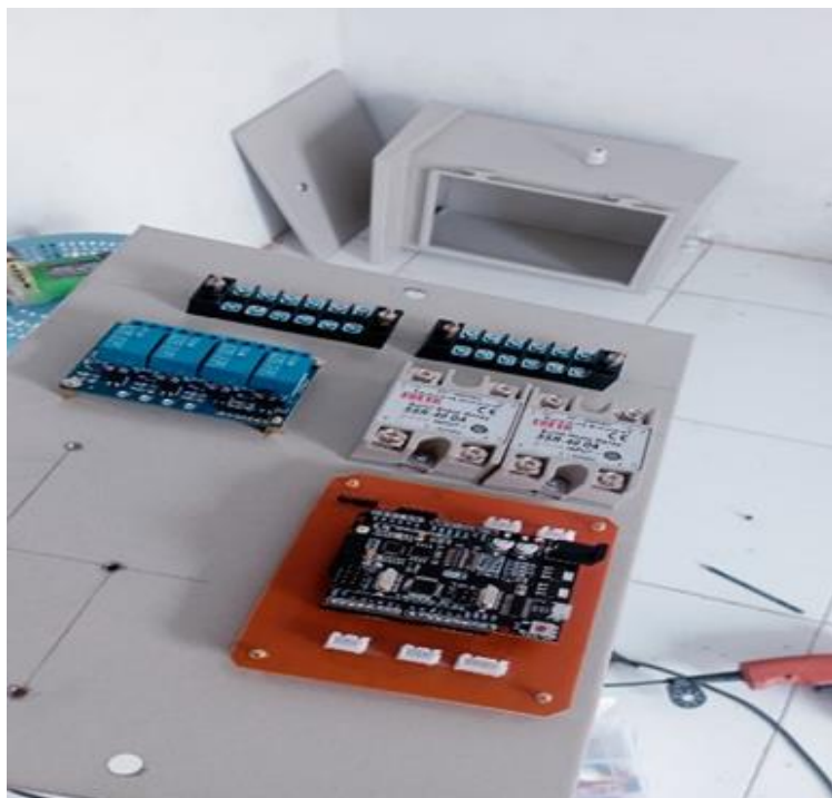
Gambar 6. Pemasang komponen Elektronika pada panel Listrik
