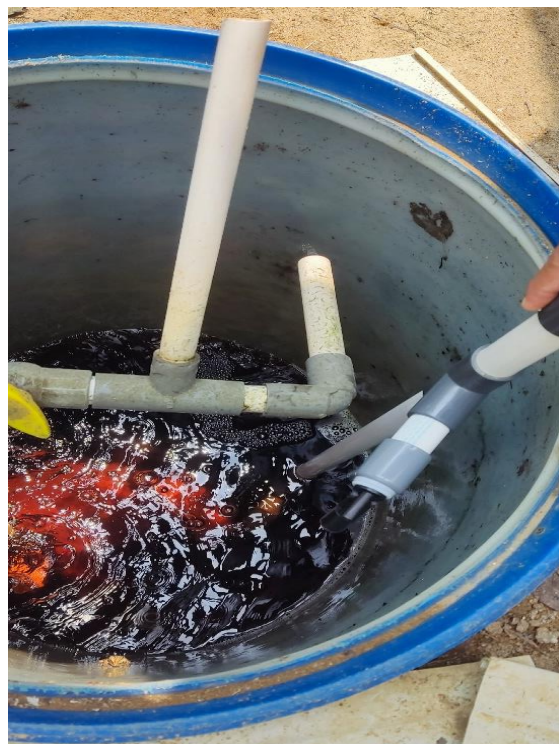
Gambar 9 Pemasangan sensor level switch
