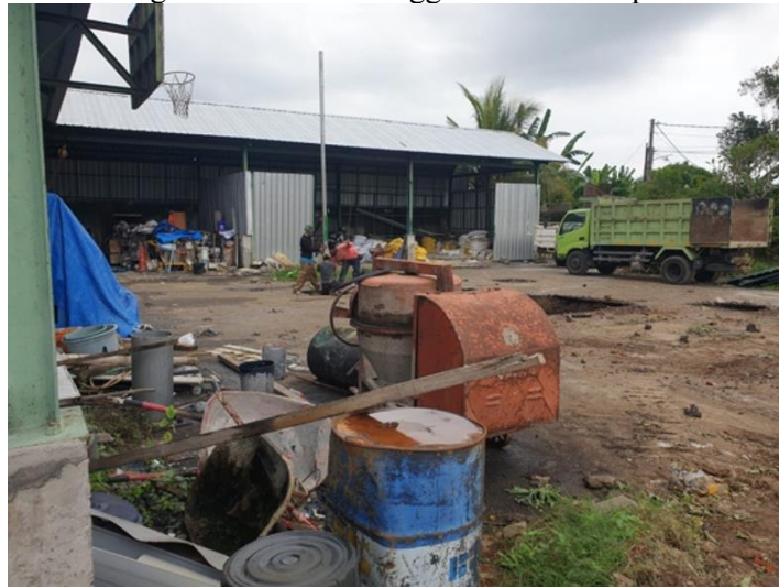
Gambar 3. Kondisi Eksisting Pabrik Paving dan Batako
