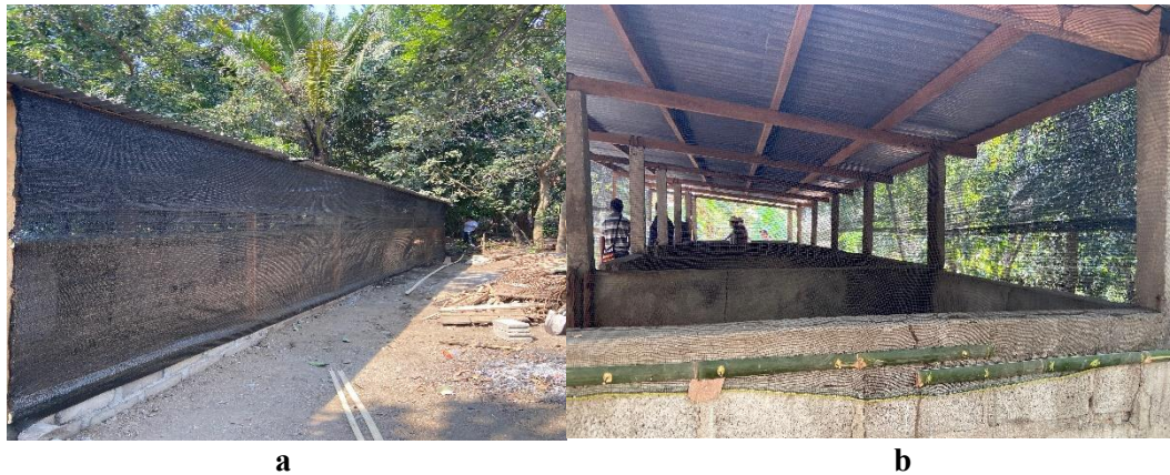
Gambar 3a. Dinding Kandang Menggunakan Para Net . Gambar 3b. Jendela Kandang Menggunakan Insect Net .
