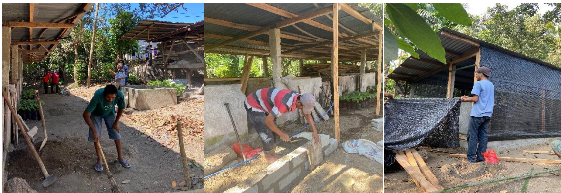
Gambar 2. Pembersihan Lokasi Kandang, Pembuatan Fondasi Dinding dan Pengukuran Para Net dan Insect Net.
