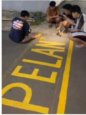
Gambar 1. Proses Pengecatan Rambu Perintah
